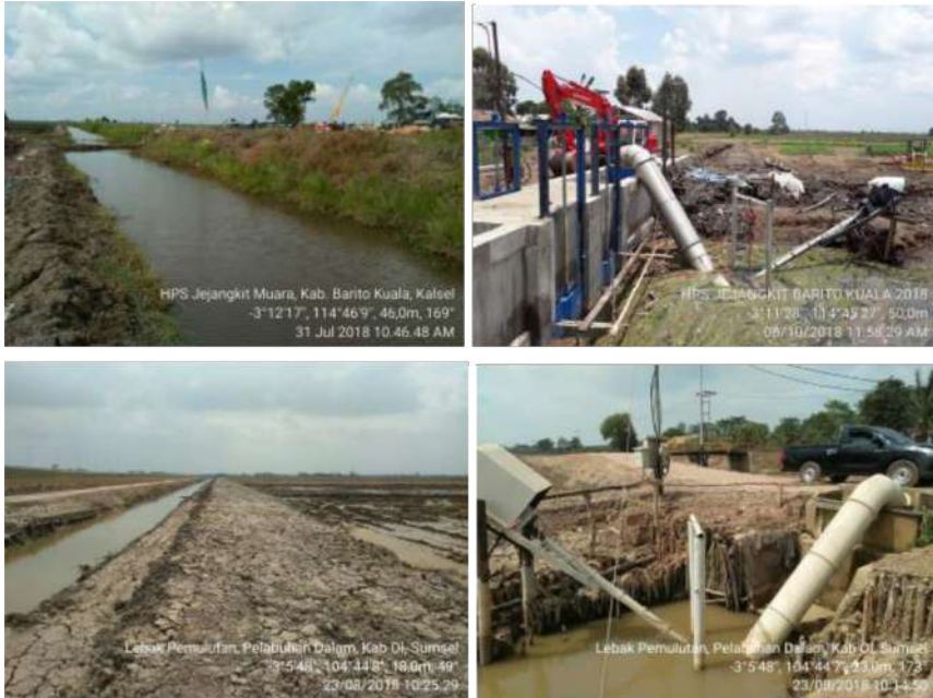
Gambar 1. Bangunan mini polder di rawa lebak di Desa Pamalutatan, Kabupaten Ogan Ilir, Sumatera Selatan dan Desa Jejangkit Muara, Kabupaten Barito Kuala, Kalimantan Selatan
