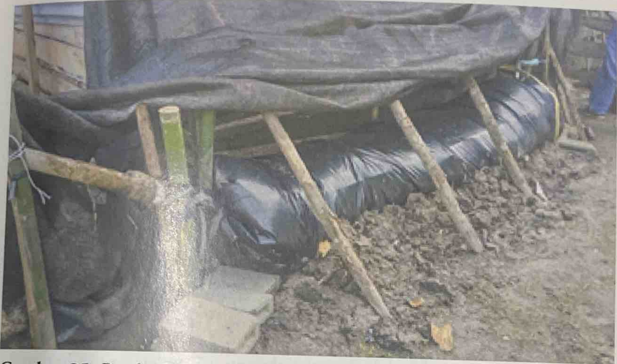
Gambar 25. Pembuatan biogas menggunakan kantong plastik hitam besar, selang, kran
