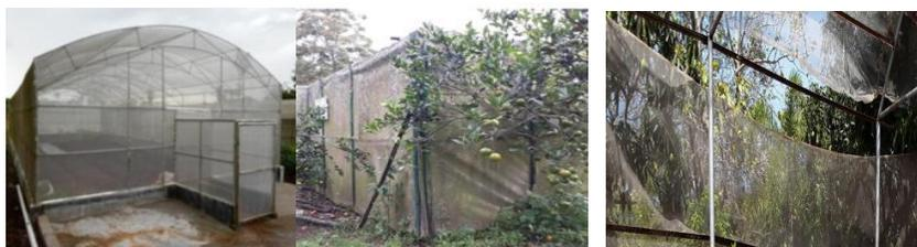
Gambar 3. Bangunan BPMT berangka besi (a), kayu (b), rusaknya kasa bangunan yang menggunakan kerangka besi (c) (Sumber :Hardiyanto *et al*, 2015)
