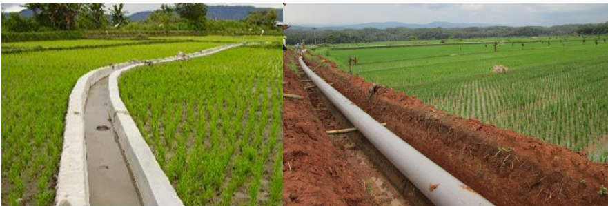
Gambar 14. Jaringan saluran air sistem terbuka (atas) dan sistem tertutup (bawah)
