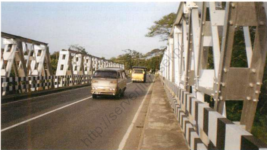
Gambar 3. Perubahan transformatif: Jalan Raya Cimalaka, Sumedang.
