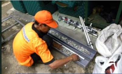
Proses peletakkan paralon di atas susunan zeolit besar.
