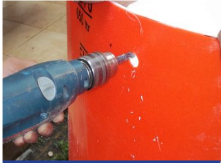
Proses melubangi tandon dengan mesin bor
