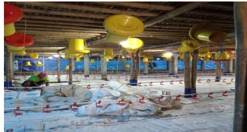
Gambar 11. Pemasangan Alas Kandang
