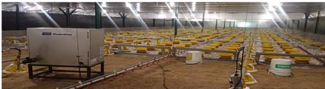
Gambar 7. Pemanas Otomatis sebagai Brooder Pada Masa Brooding
