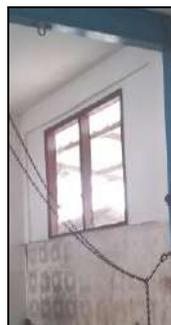
Ventilasi udara yang berlebihan atau jendela kaca yang tidak menutup secara penuh masih memungkinkan lalat atau serangga masuk ke dalam ruang penyembelihan.
