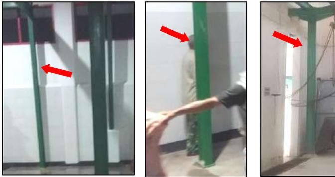
Tiang kolom dipasang setelah bangunan berdiri. Ada celah  $\pm$  30 cm diantara tiang kolom dan dinding dalam.
