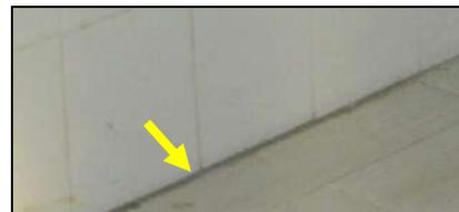
Antara dinding dengan dinding atau lantai dengan dinding bersudut lancip sehingga sulit dibersihkan.
