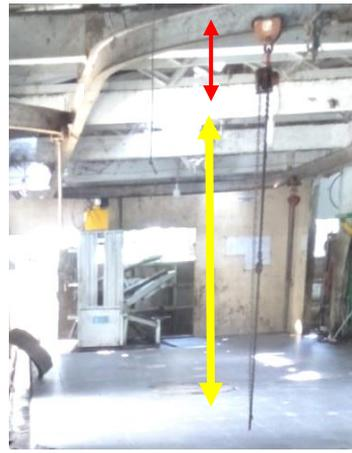
Tinggi rel, setelah dikurangi panjang *trolley* rel, katrol dan *spreader* tidak cukup untuk menggantung sapi / karkas secara penuh.
