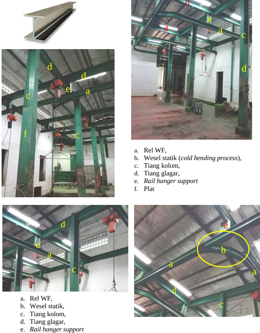
Gambar 137. Sistem Rel WF - KMA.
