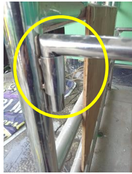
7. Memasang penghalang atau pintu RB memakai sistem engsel dan selot
