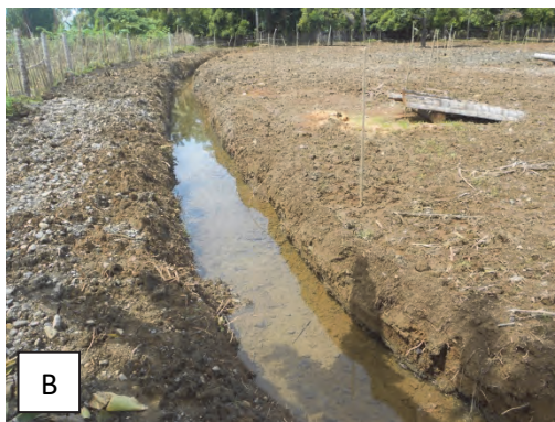
Gambar 1. (A) penebangan pohon dan (B) pembuatan saluran drainase
