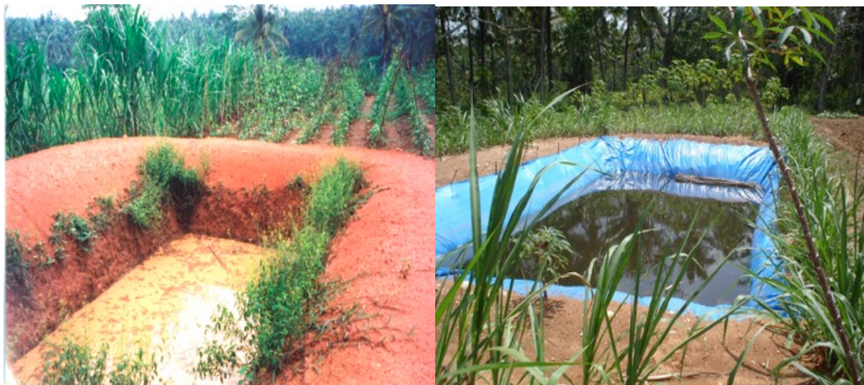
Gambar 2. Kolam pemanen air hujan tanpa penguat dinding (A) dan dilapisi plastik kedap air (B) pada areal usaha tani tanaman sela (tanaman sayuran diantara tanaman lada) di Lampung (Sumber: Hafif, koleksi pribadi)
