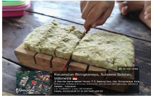
Gambar 43. Pemotongan Rockwool
