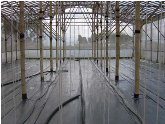
Gambar 13. Pemasangan plastik perak pada lantai rumah kasa) (Foto : Tonny K. Moekasan)
