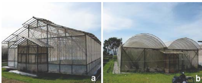
Gambar 2. Rumah kasa bambu dengan bentuk atap punggung babi (a) dan rumah kasa kayu besi dengan bentuk atap tanel (b) (Foto : Tonny K. Moekasan)
