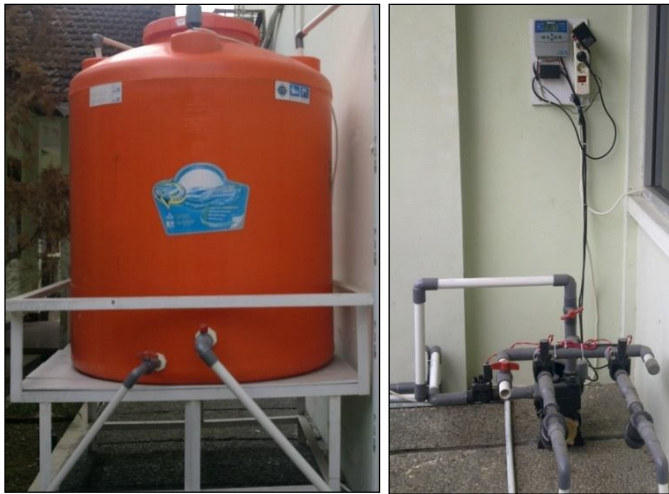
Gambar 28. Water torn sebagai sistem penampung air (kiri), b) sistem pengatur waktu (kanan)
