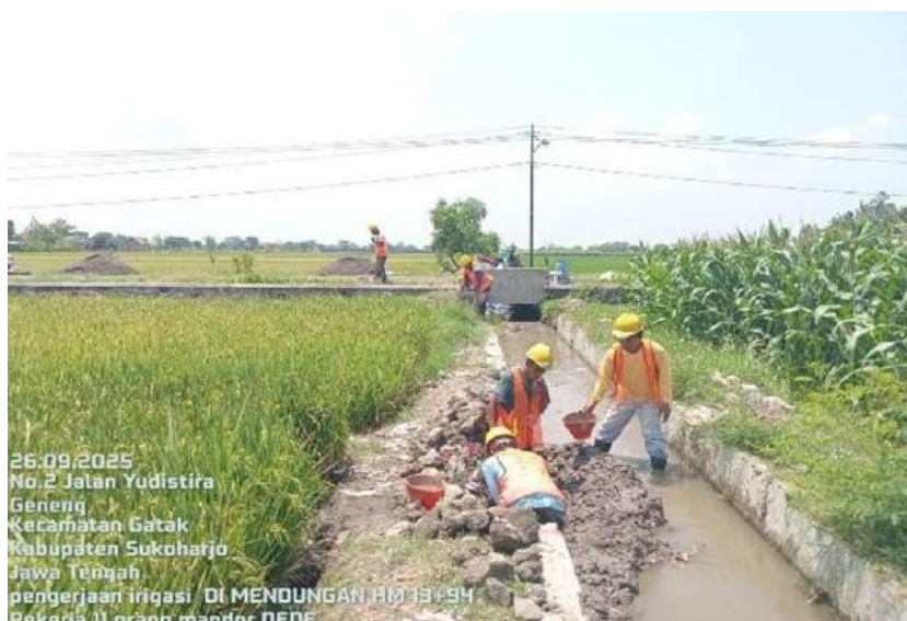
Gambar 4.5. Perbaikan Jaringan Irigasi Tersier
