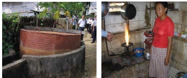
Gambar10.8. Digester sederhana yang terbuat dari beton (digester) dan drum bekas (gas-holder/penampung gas) (kanan) dan kompor berbahan bakar gas-bio untuk memasak (kiri)
