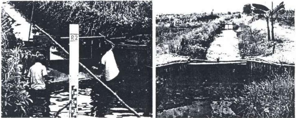
Gambar 36. Sistem tabat (canal block) di lahan gambut
