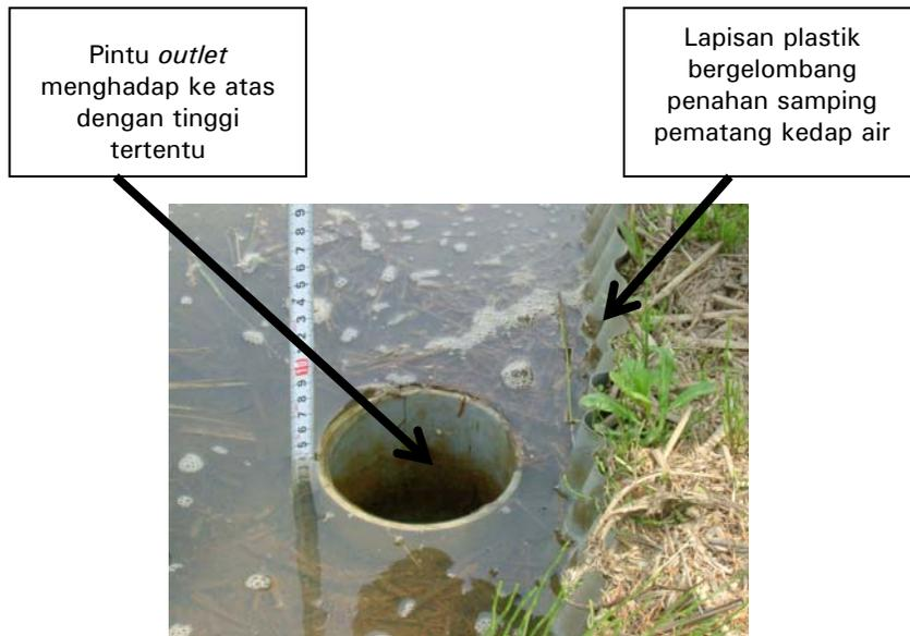
Gambar 3. Skema *low drainage gate* pada petakan sawah
