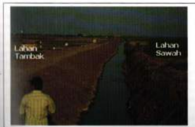
Gambar 4. Drainase yang dibuat sebagai pembatas lahan (Foto: Deddy Erfandi)
