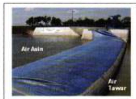
Gambar 6. Bendungan karet sebagai penghambat intrusi air laut. (Foto: Deddy Erfandi).
