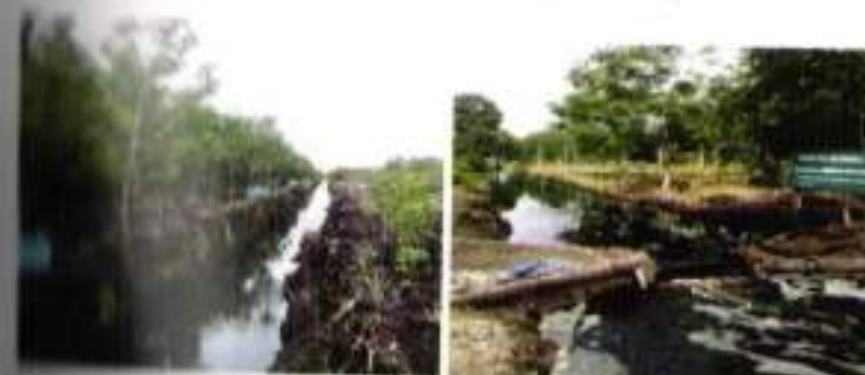
Gambar 5. Saluran drainase pada lahan gambut (kiri) dan pintu air pengontrol kedalaman muka air di saluran drainase (kanan) (Foto: Maswar)
