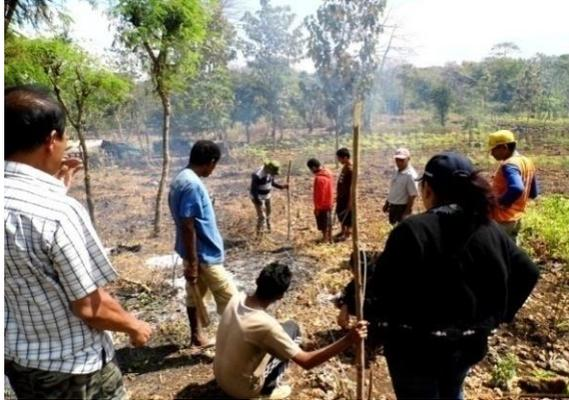
Gambar 12. Membuat titik beda tinggi menggunakan selang berisi air
