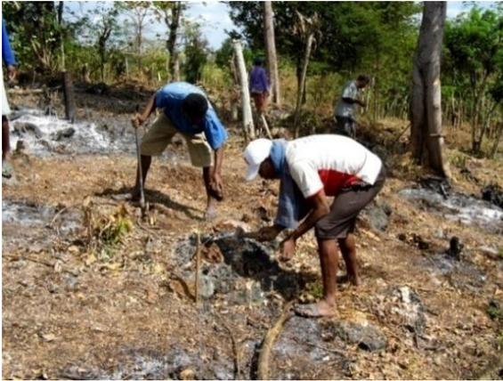
Gambar 15. Proses pembuatan teras batu
