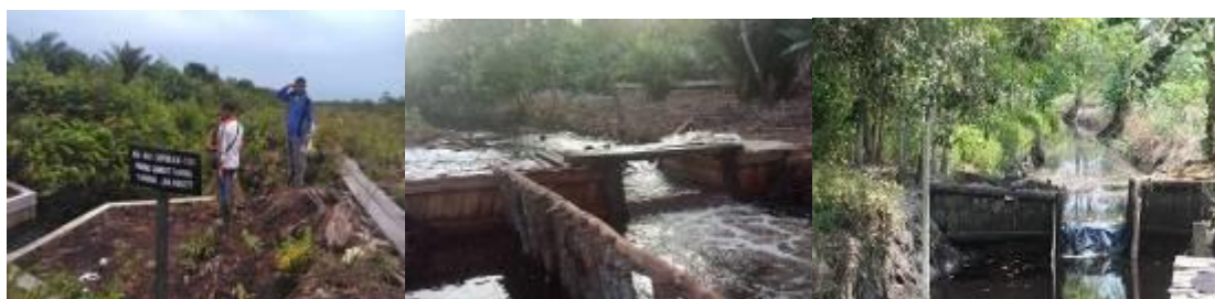
Gambar 1. pengaturan tata air pada lahan gambut
