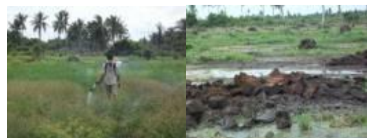
Gambar 8. Penyemprotan gulma dan pembongkaran tunggul Tunggul kayu/kelapa
