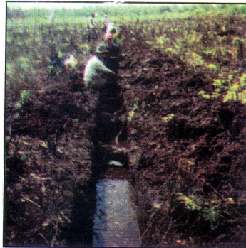
Gambar 2 Pembuatan saluran air dilahan gambut
