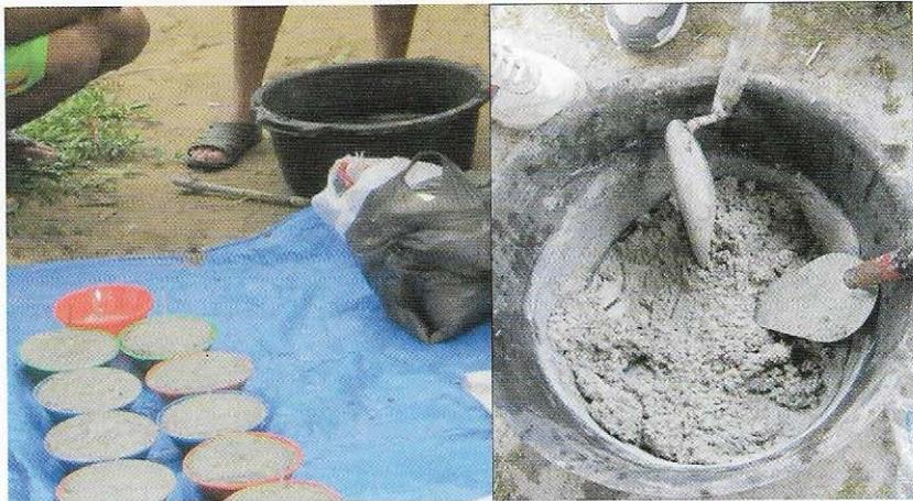
Gambar 12. Proses pencetakan dan penjemuran mineral blok
