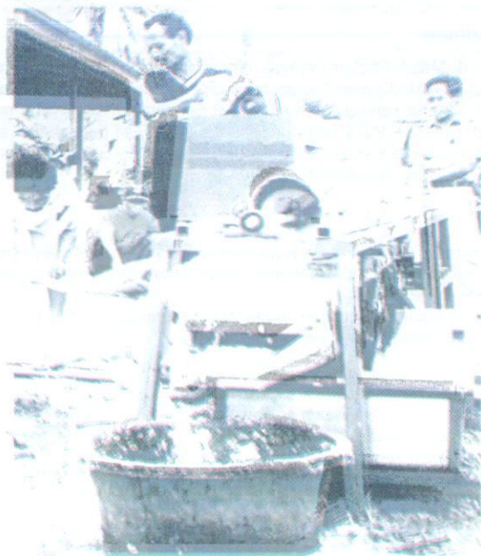
Gambar 1. Pengolahan sagu dengan alat mekanis sistem terpadu
