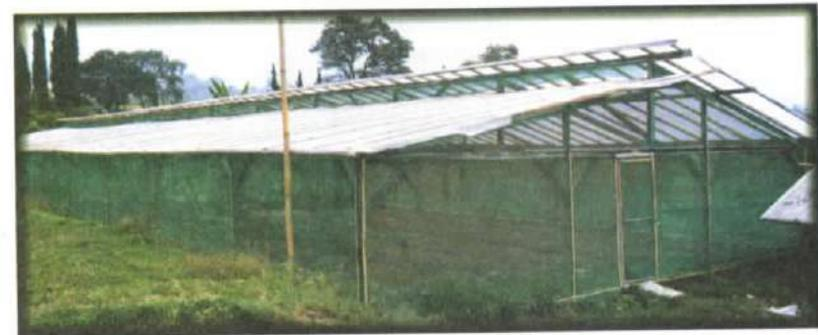
Gambar 2. Contoh rumah lindung dengan konstruksi kayu, atap plastik UV dan dinding kain kasa
