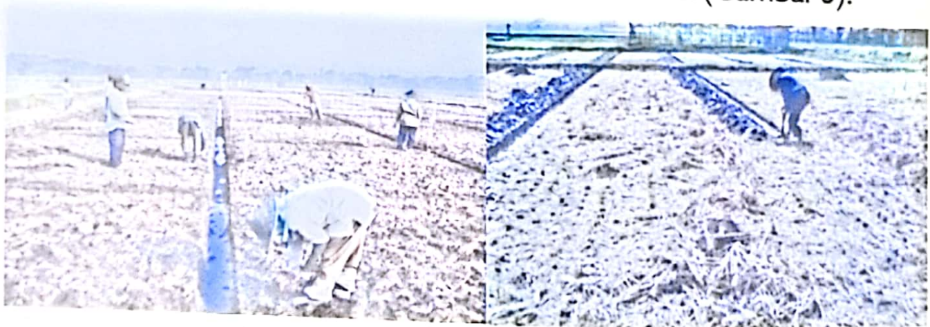
Gambar 3. Pembuatan saluran drainase
