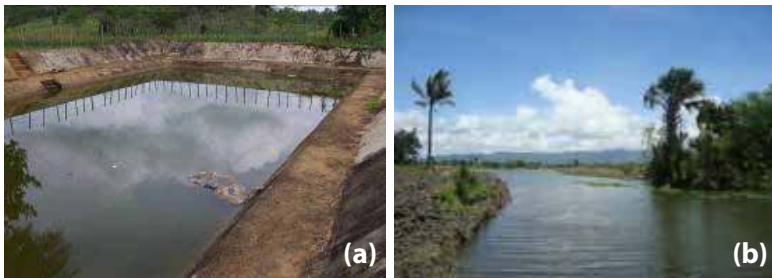
Gambar 23. Embung konstruksi pasangan batu di Gunung Sugih, Lampung Tengah (a) dan embung lapisan tanah di Naibonat, Kupang (b)
