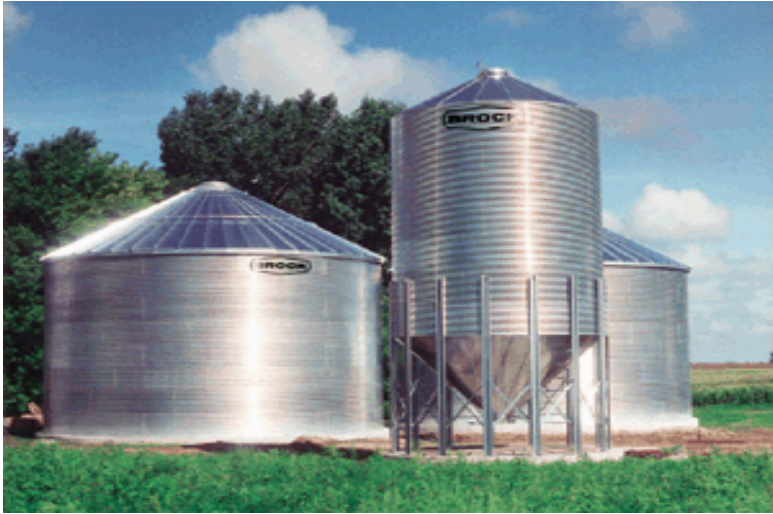
Gambar 77. Silo untuk penyimpanan biji-bijian kering
