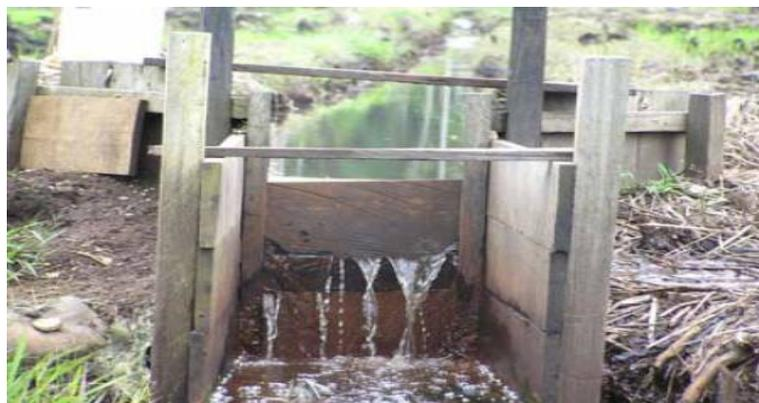
Gambar 26. Pintu air yang berfungsi sebagai *canal blocking* untuk menjaga muka air tanah tetap stabil pada kisaran yang dikehendaki
