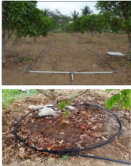
Gambar 13. Instalasi sistem irigasi fan jet sprayer pada pokok tanaman buah-buahan di Kebun Percobaan Taman Bogo, Kecamatan Purbolinggo, Kabupaten Lampung Timur, Provinsi Lampung.
