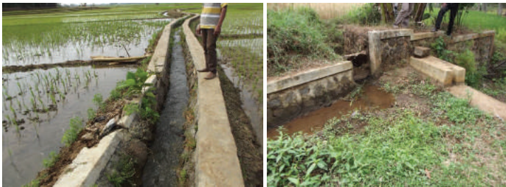
Gambar 8. Perbaikan Saluran Irigasi di Desa Setupatok, Kecamatan Mundu dan Pembersihan Sedimen Dam Parit di Desa Sindangkasih Kecamatan Beber, Kabupaten Cirebon
