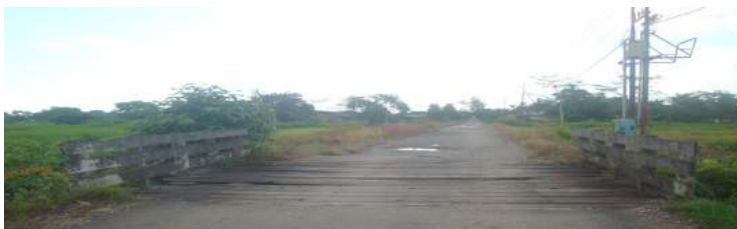
Gambar 3. Jembatan Kayu di jalan utama Kecamatan di Kab. Batola
