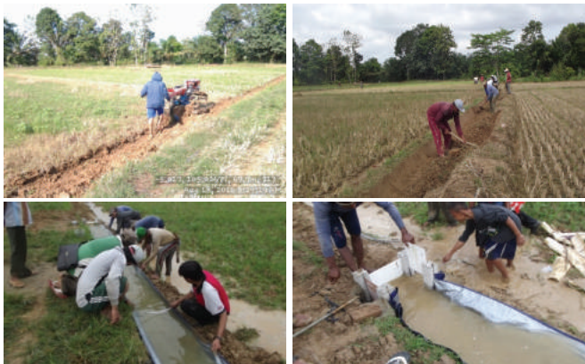
Gambar 5. Persiapan Pemasangan Saluran dan Tes Saluran serta Bak Bagi di Lahan Sawah, di Dusun Bumi Udik, Kecamatan Anak Tuha, Kabupaten Lampung Tengah
