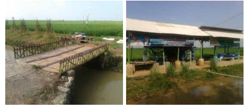
Gambar 32. Pembangunan jembatan dan rumah pompa dari hasil pengelolaan air tanah
