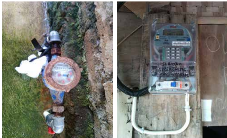
Gambar 29. Pemasangan flow meter dan kWh meter
