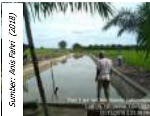
Gambar 2. Embung kapasitas 1.000 m<sup>3</sup> Kabupaten Bengkalis
