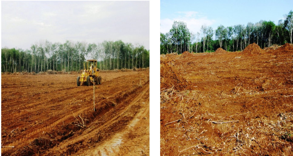
Gambar 1. Perataan area dengan Road Greder
