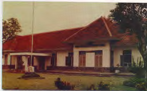
Gambar 32. Gedung Kelti Bakteriologi saat ini.
