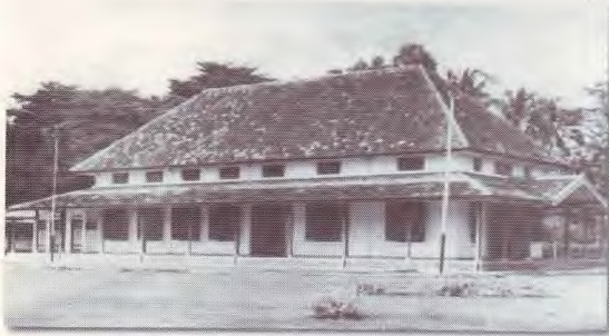
Gambar 28. Gedung Parasitologi (sekarang Seksi Rencana Kerja)
